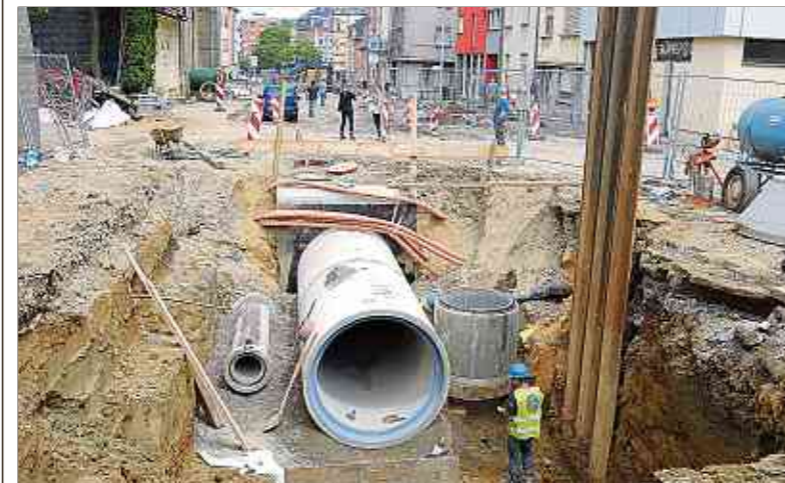
Unter der neuen Groussstrooss befindet sich unter anderem eine Abwasserleitung mit 1,6 Metern Durchmesser. Sie ersetzt den engen und mehr als hundertjährigen alten Kanal. (FOTO: LUC EWEN)
