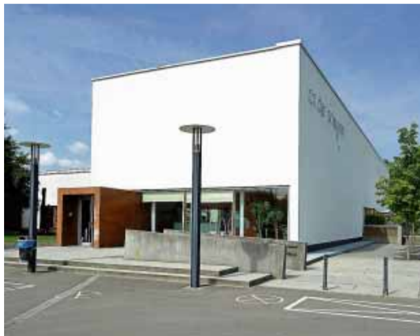
Eine Seite der Fassade musste von Algen befreit werden
